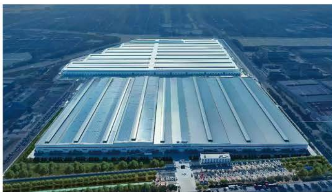
新能源用变压器生产基地
